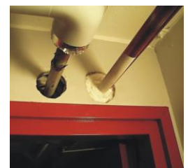
Rör genomföring utan och med brandtätning
